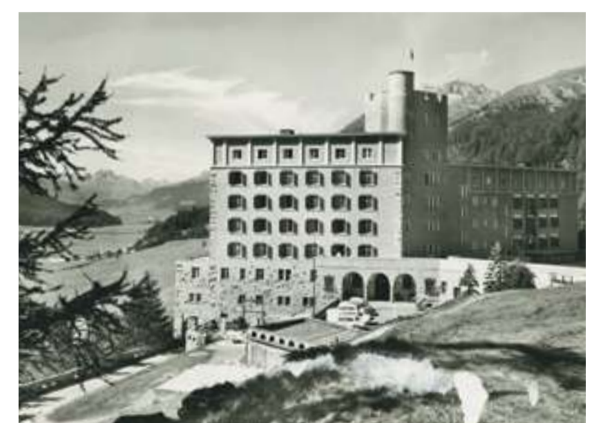
DAS CASTELL KURZ NACH DEM BRAND UND DER RENOVATION
